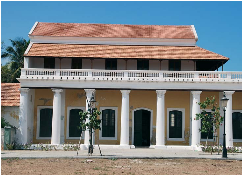
Huset hvor guvenør Peter Anker boede, efter en omfattende renovering støttet af Nationalmuseet i København. (Foto: Trankebar Forening)
